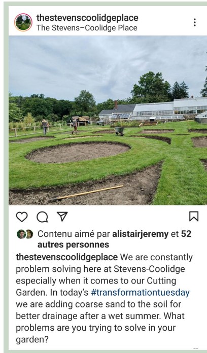
Figure 4. Publication sur le compte Instagram de SCHG. Après un été pluvieux, le nouveau jardin de fleur à couper situé au sud du domaine a subi des travaux pour améliorer son drainage. Gracieuseté du Stevens-Coolidge House & Gardens
